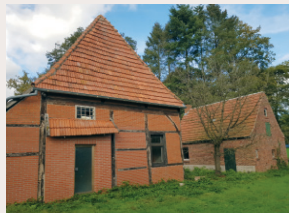
Die Rückseite des Hauses Rickhoff mit angrenzender Futterküche auf der rechten Seite
